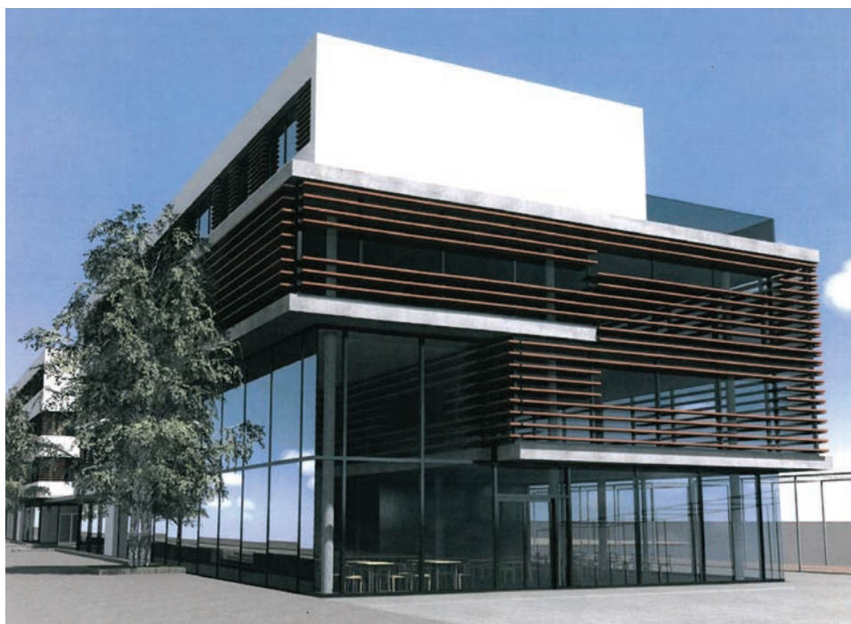
Centre “Boléro” à Versoix, façade sud
